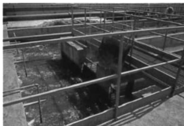
Дальнейшая обработка может быть улучшена добавлением двухступенчатой фазы фильтрации – флокуляция и стерилизация – после фазы осаднения. В результате чего получают исключительно высокое качество обработанной воды с минимальным содержанием взвесей.
